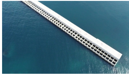
▲ 発電を行う釜石湾防波堤
