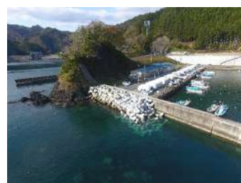
両石漁港漁港施設機能強化（護岸（改良）その2）工事
