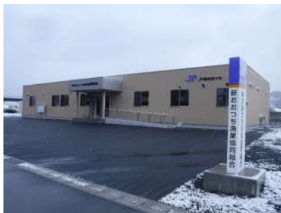
新おおつち漁業協同組合事務所新築工事
