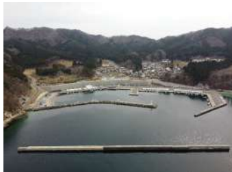
白浜（鵜）漁港漁港施設機能強化（防波堤（改良）ほか）工事
