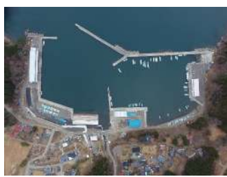
白浜（釜石）漁港海岸災害復旧工事
