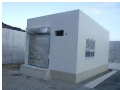
平田漁港海岸災害復旧（電気室）工事
