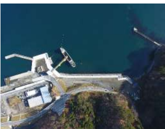
大槌漁港県単災害復旧（護岸その2）ほか工事
