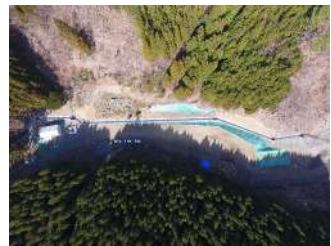
東京大学地震研究所釜石海底地震観測点災害復旧工事
