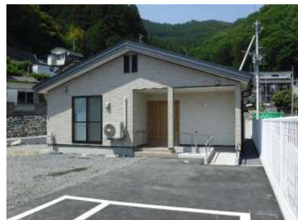
新浜町地区集会所建設工事
