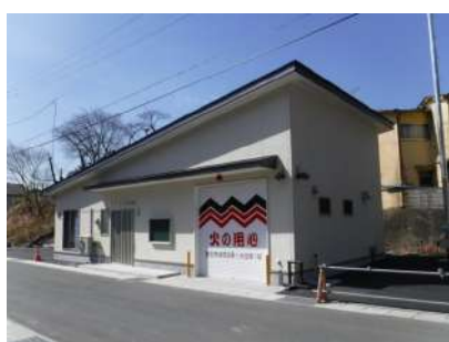
東前地区消防屯所建設工事
