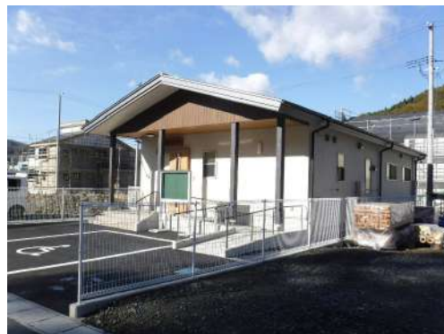
東前地区集会所建設工事
