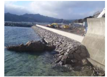
H30大槌漁港県単災害復旧（護岸）工事
