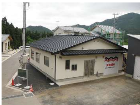
箱崎白浜地区消防屯所建設工事
