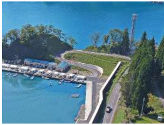
両石漁港災害復旧（646号臨港道路）工事
