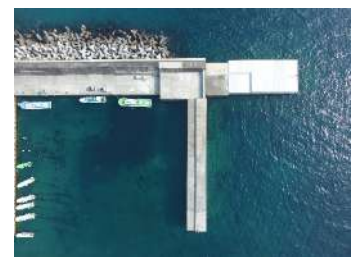
H30仮宿漁港災害復旧工事
