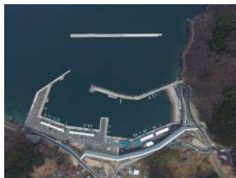
白浜（鵜）漁港災害復旧工事
