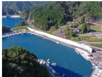
両石漁港海岸災害復旧工事
