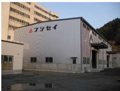
フジセイ事務所・倉庫新築工事
