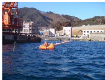
東京大学取水管設置工事
