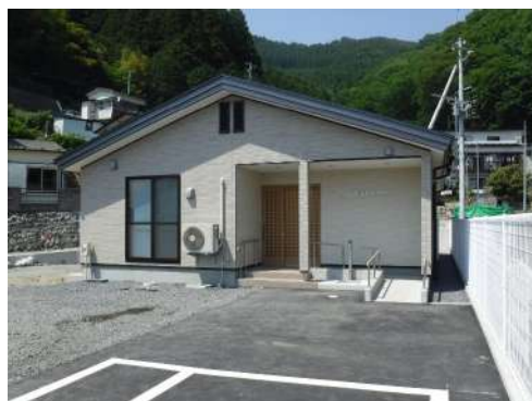
新浜町地区集会所建設工事
